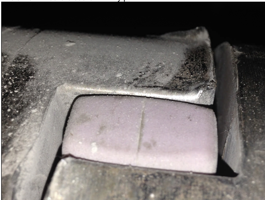
Рис 3. технического состояния муфты:
